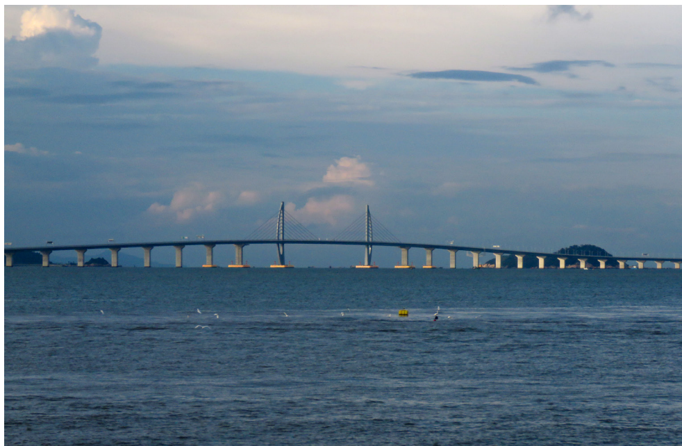
Puente Hong Kong Zhuhai, Macao, China. (Fuente: Wikimedia Commons).
