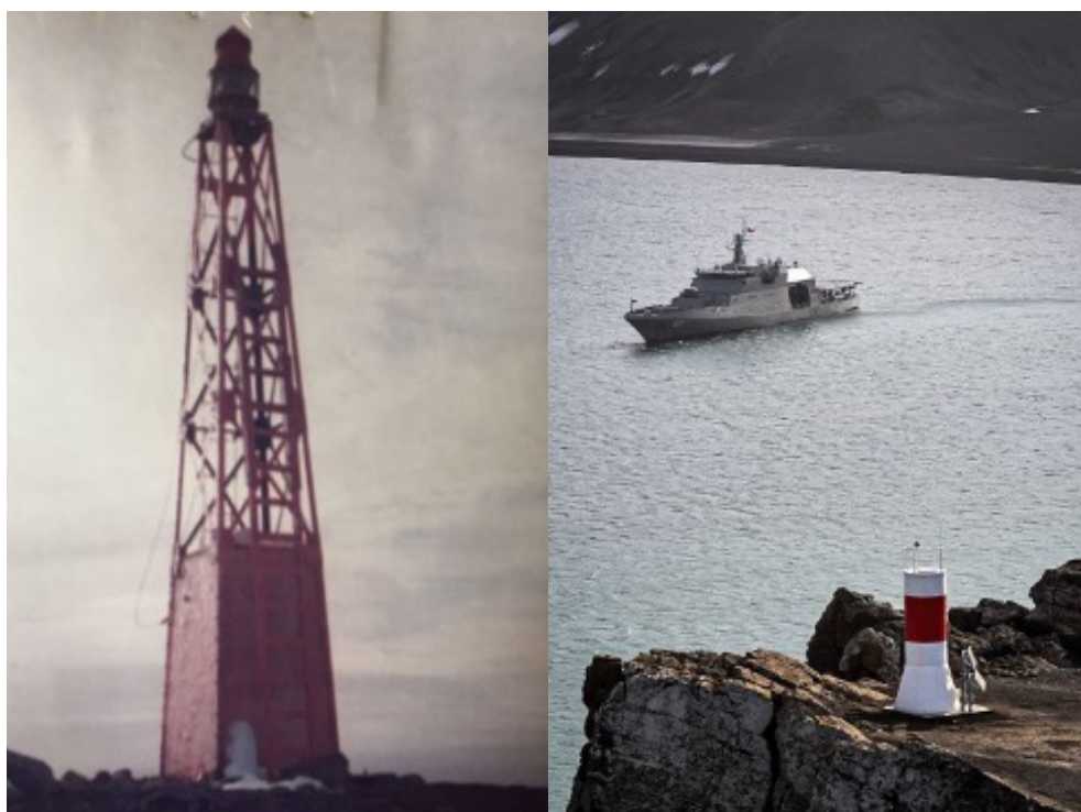
Imagen izquierda: Faro Punta Prat 1947, automático, alimentado por un banco de gas acetileno que destellaba con intervalos de 10 segundos. Imagen derecha: Faro "Piloto Pardo" instalado por el OPV "Fuentealba" de la Armada de Chile en isla Decepción en el TCHA. (Fuente: Autor artículo)
